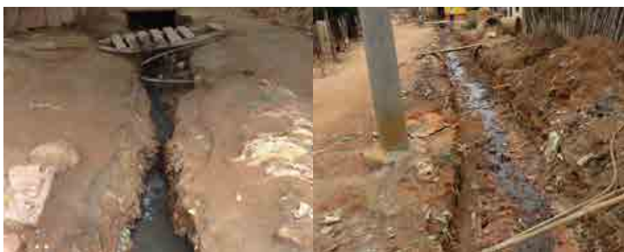
Vertimientos de las viviendas que descargan sus aguas a las minas y ayudan a desestabilizar el suelo. Fuente: Defensoría del Pueblo, 2015.
