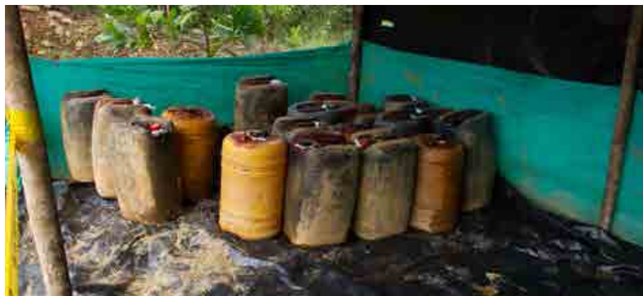
Depósito de combustibles almacenados de forma antitécnica. Obsérvese que no existe protección contra derrames ni de incendios. Fuente: Defensoría del Pueblo, 2015.
