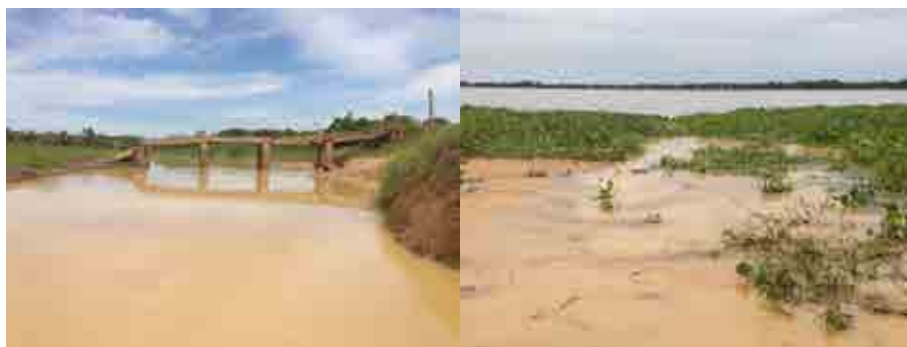
Quebrada Quebradona cargada de sedimentos en sitio próximo a su desembocadura en la ciénaga de Ayapel. Foto: Defensoría del Pueblo.
