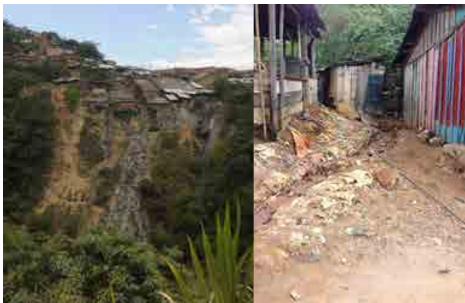
Explotación en Marmato, Caldas. Zona de alto riesgo.
